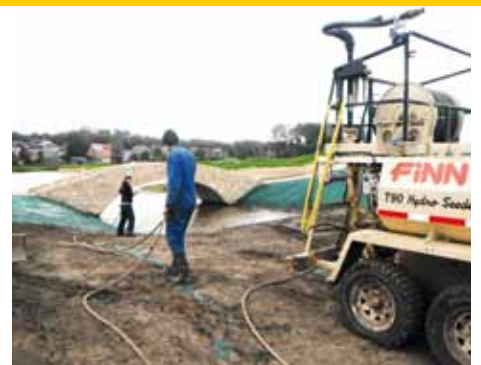
Hydroseeding van hole 3-4, met een nieuw Amerikaans systeem.
