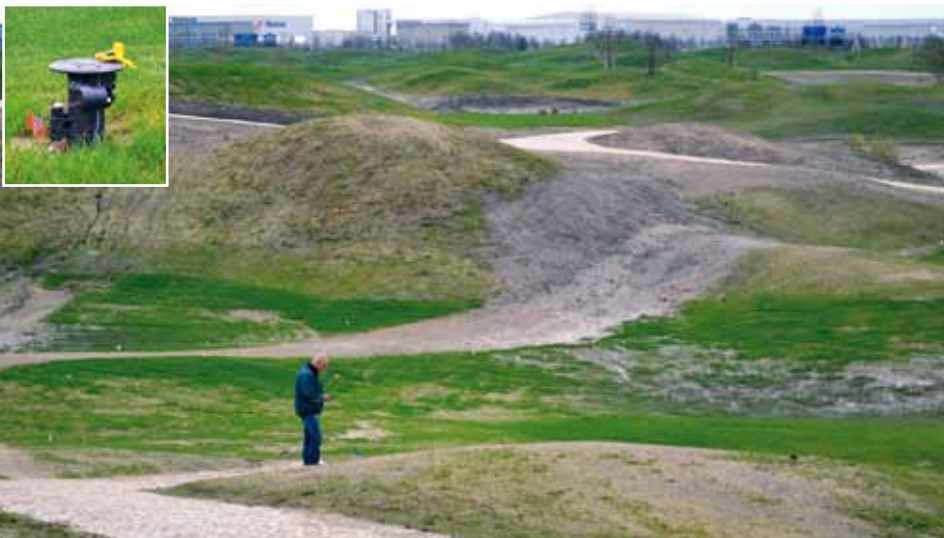
Specialisten van Aquaco testen het beregeningssysteem. De stand van de popups moet nog bijgesteld worden.
