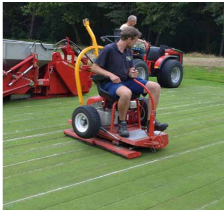
Tweemaal in de lengterichting rollen.
