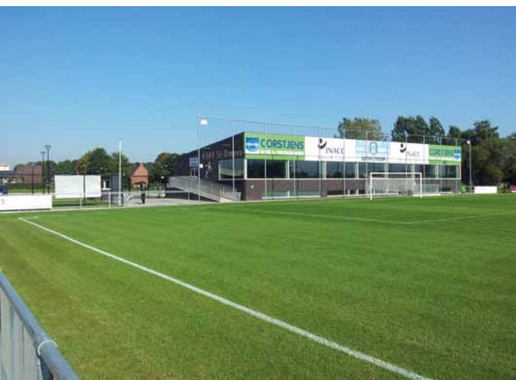
In Geel is twee jaar geleden een toplaag volgens de Ganda-normen aangelegd. Het onderhoud is anders, maar er wordt nu al op bespaard. In de zomer moet er meer gesproeid worden; in de winter laat het veld meer water door, waardoor er veel minder herstelwerkzaamheden nodig zijn.
